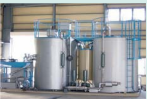
■ 日工株式会社 10m 3 /日産廃排水処理設備 高負荷・高変動排水の安定処理に成功
